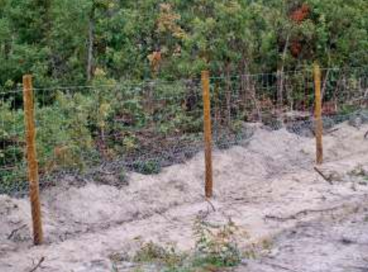
Construcción de cercados
